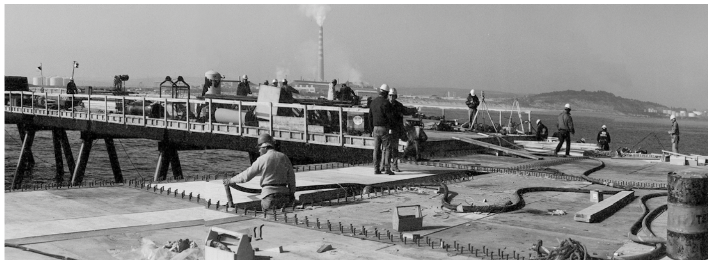
Obras de ampliación del puerto, sitio 5.
