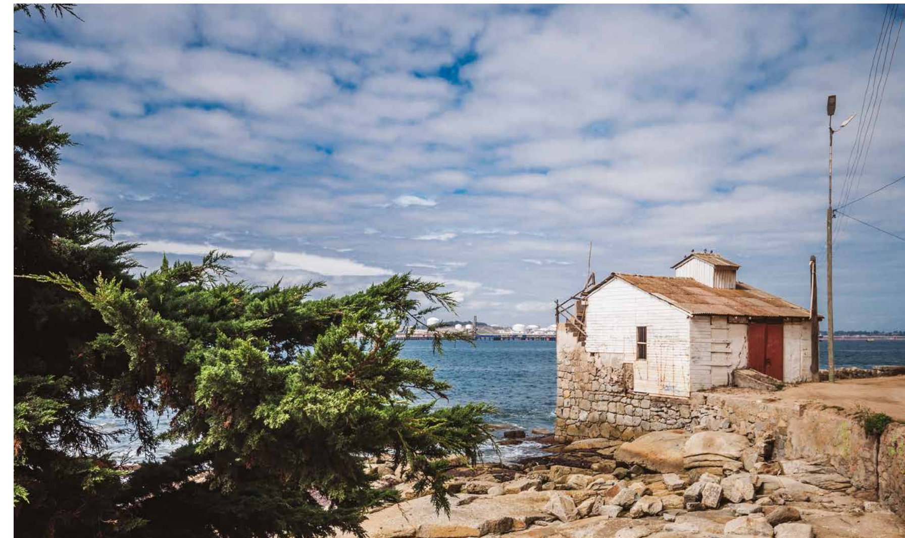
Casa de bombas de la salina, caleta Ventanas.
