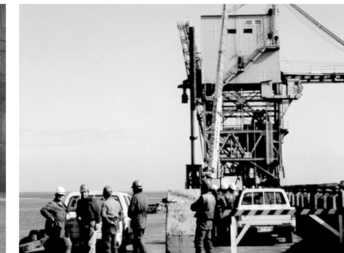
Obras de adecuación a nuevas instalaciones.
