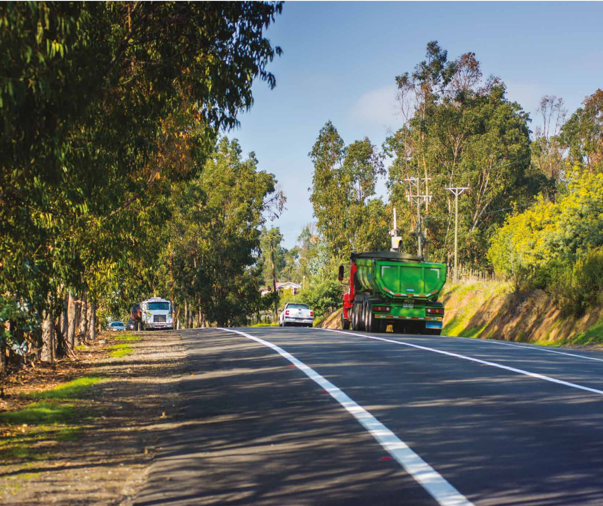
Carretera en Puchuncaví.
