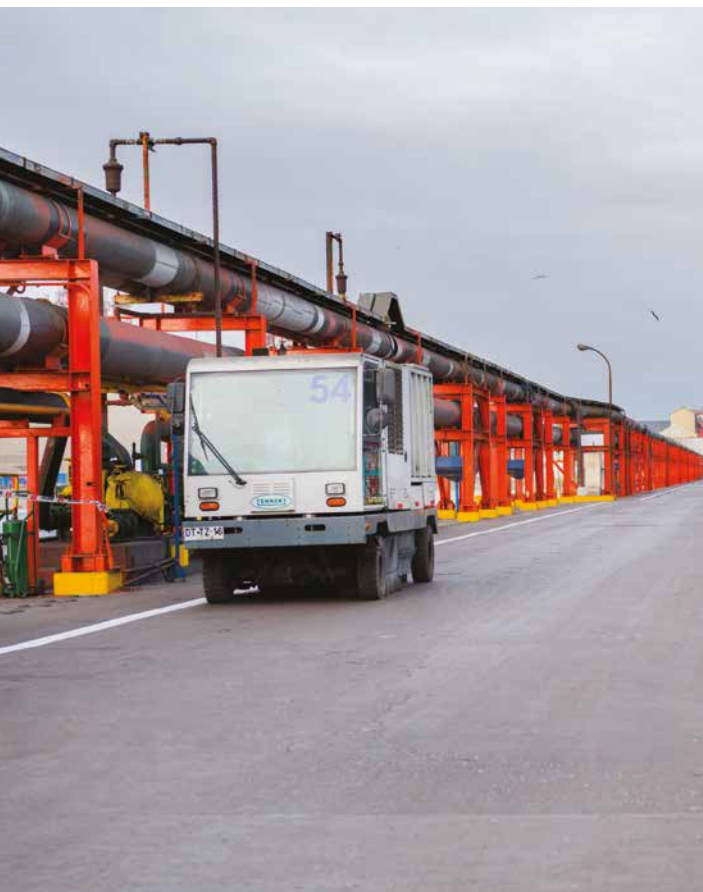
Calle de acceso con aspiradora de polvo.
